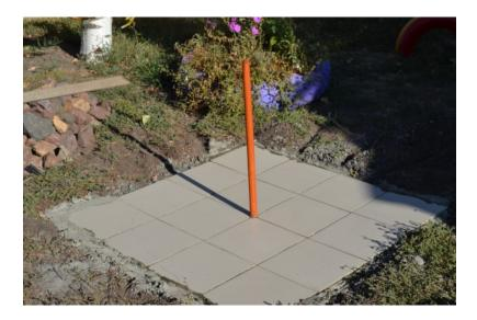
Через сутки площадка для циферблата готова. С помощью карандаша и линейки, отмеряя равные отрезки от центра к краю, начертите круг на плитке. Затем нанося плиточный клей по контуру круга в два ряда выложите щебенку, как мозаику.
